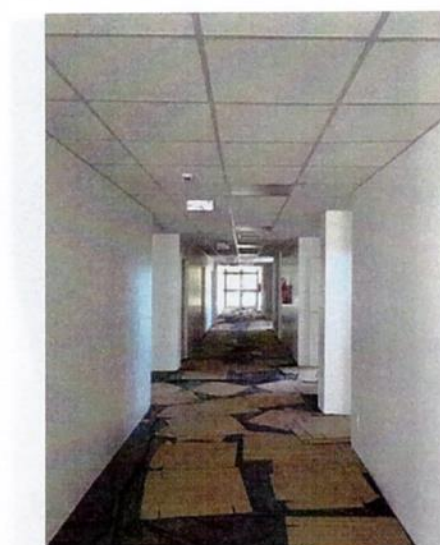
Foto 10 – Corredor bloco A
