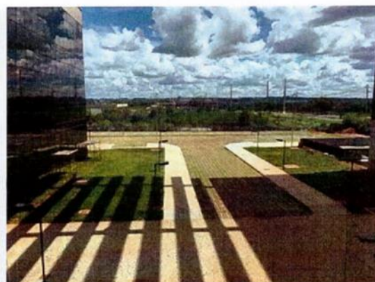
Foto 12- Vista da passarela
