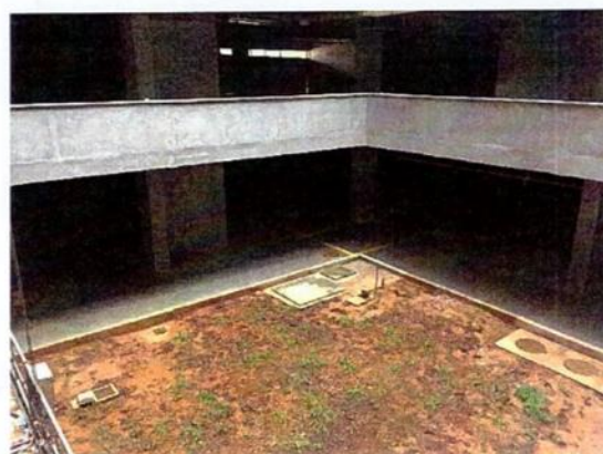
Foto 5 – Vista do subsolo, vão principal
