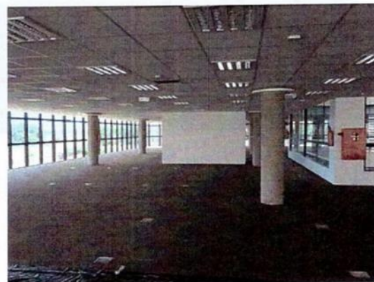
Foto 6 – Área administrativa bloco A
