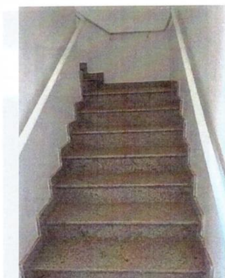
Foto 9 – Escada saída de emergência
