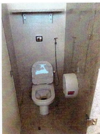
Foto 15 – Sanitário dos banheiros
